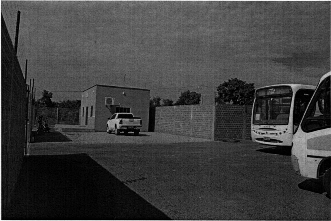
GARAGEM DE VEÍCULOS E MÁQUINAS
